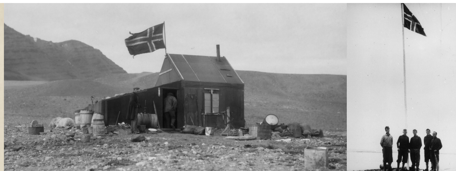
Oppføring av fangsthytter var en effektiv måte å demonstrere at et område ble brukt av nordmenn. Dette bildet viser hytta på Kap Herschell, bygget av medlemmer av Hird-ekspedisjonen i 1927. Foto: Norsk Polarinstitut
